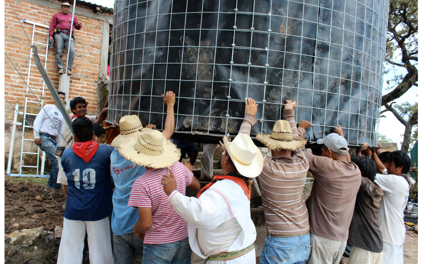
Instalación de un SCALL comunitario. Foto: Archivo Ha Ta Tukari.
