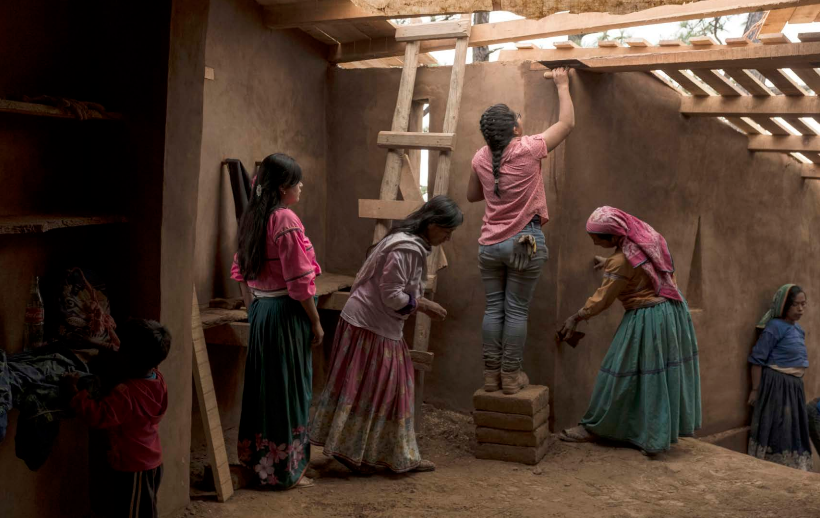
Repello del área de la clínica en el Centro Comunitario de La Cebolleta. Foto: Cate Cameron.
