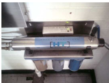
Figura 5.12. Lámpara de luz UV contra microorganismos para potabilización de agua.
