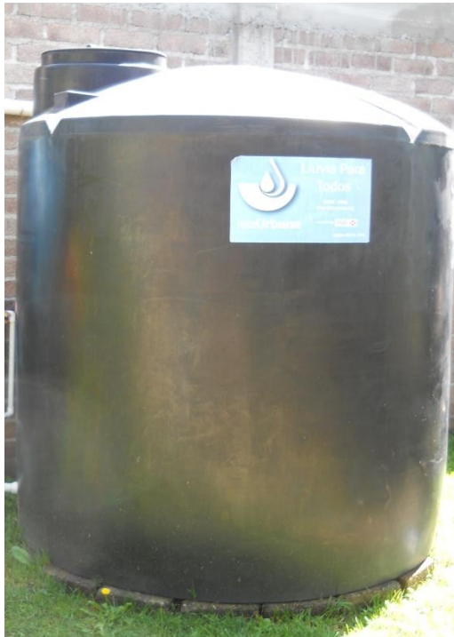
Figura 7. Tinaco implementado por Isla Urbana (izq.) empleado como tanque de almacenamiento. Cisterna enterrada (der.) utilizada para almacenar el agua, en lugar del tinaco.
