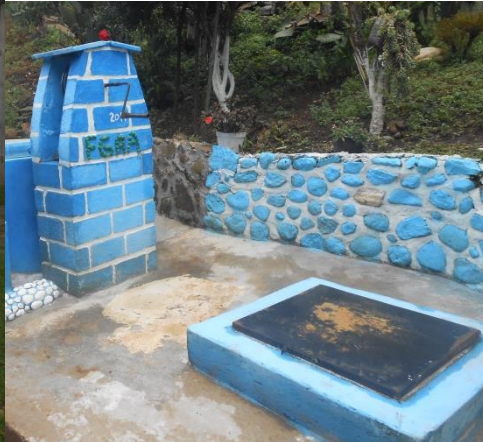
Figura 18. Cisterna enterrada de ferrocemento con tapa de herrería de un SCALL de Fondo Pro Cuenca.
