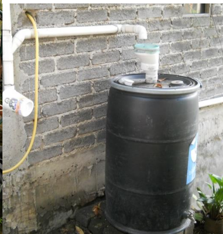
Figura 6. Tlaloque (izq.) y desviador de primeras lluvias (der.) instalados por Isla Urbana.
