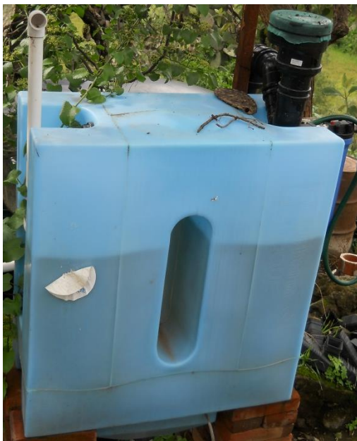
Figura 6. Tlaloque (izq.) y desviador de primeras lluvias (der.) instalados por Isla Urbana.
