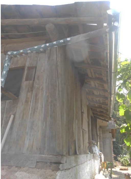
Figura 16. Canaletas y tubos de conducción del techo hacia el filtro de arena de un SCALL de Fondo Pro Cuenca.
